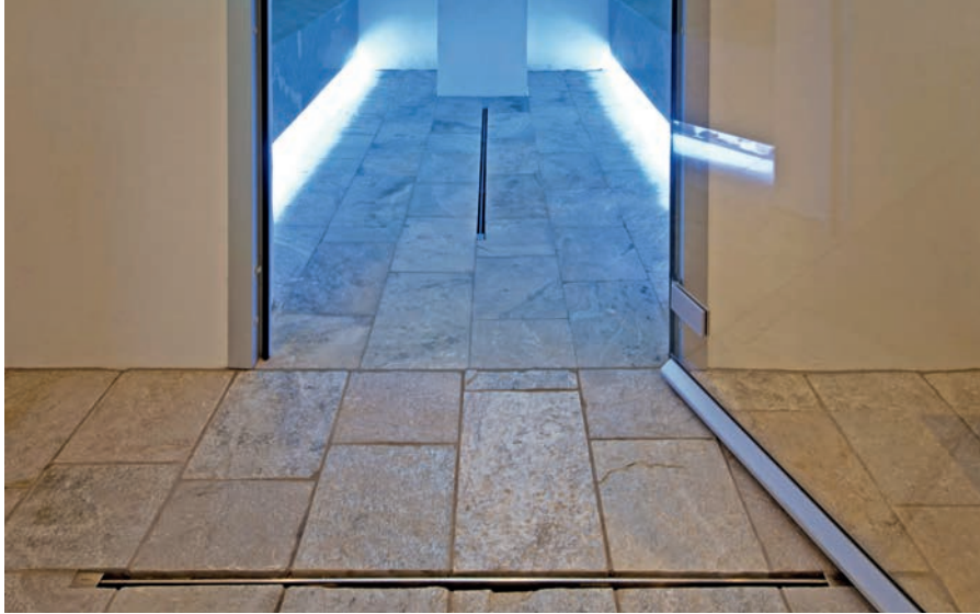
Vor der Dampfsauna reichte technisch gesehen eine auf mittlere Länge gekürzte Duschrinne. Diese Variante passt harmonisch ins gesamte Ambiente des Wellness-Bereichs.
